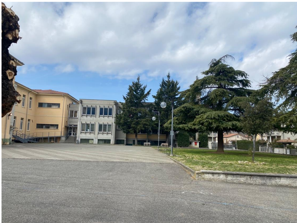
FOTO 5 - vista del complesso scolastico dal cortile interno
