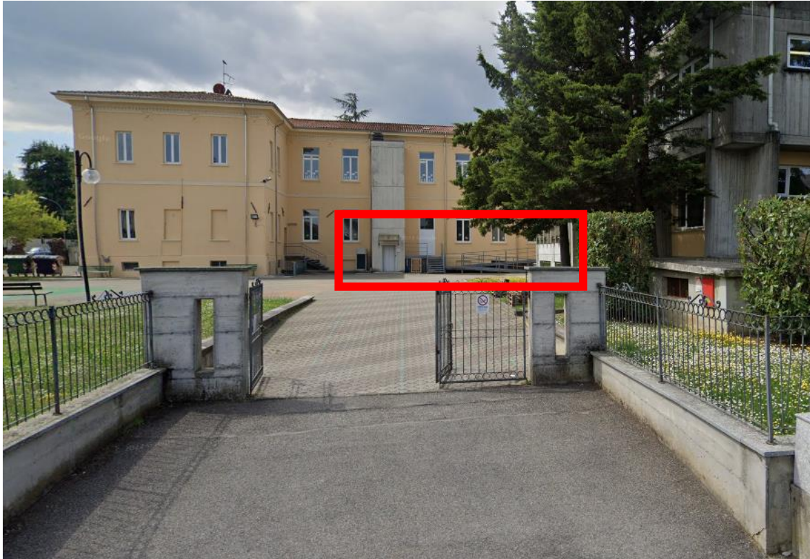
Ascensore presente nel cortile e relativa rampa esterna esistente
