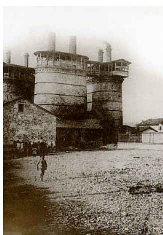
L'impianto in una foto d'epoca
